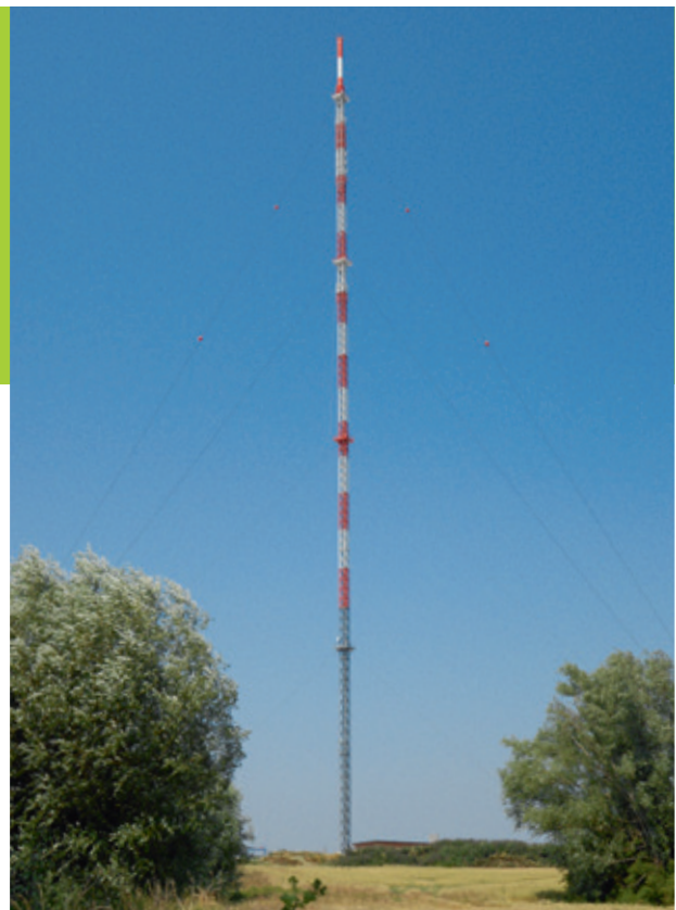
Der neue Funkturm in Rostock-Toitenwinkel im Sommer 2014.
